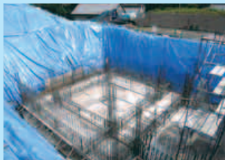
基礎工事 平成20年 7 月10日現在
